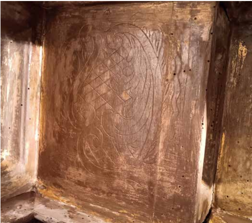
5. Imagen de los esgrafiados de los paños lisos del Carmen, prácticamente imperceptibles antes de la intervención.
