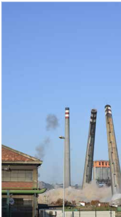
1. Voladura de las chimeneas de baterías de cok de Ensidesa en Avilés, incluidas en el Plan Nacional de Patrimonio Industrial. Foto: Rubén Domínguez Rodríguez.
