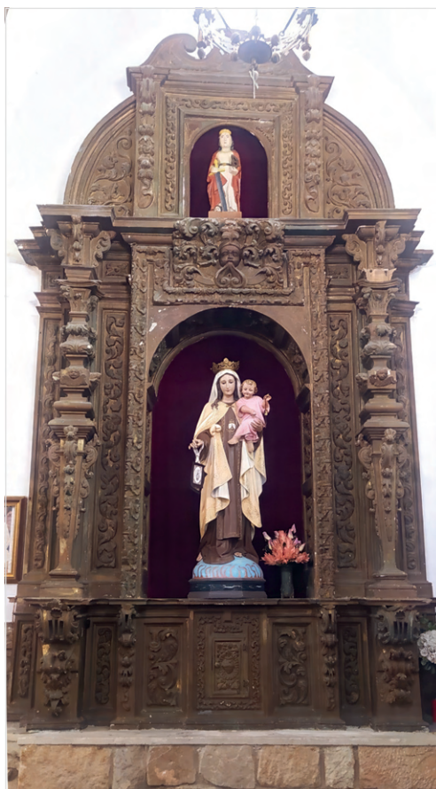
1. Estado del retablo del Carmen antes de la intervención.
