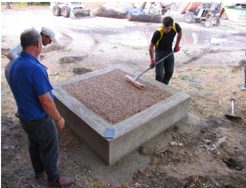
4. Relleno de la base-soporte para motor Winterthur depositado en exterior. El colmatado evita anidar a animales superiores. Pieza colección MUNCYT. Fotografías: Joaquina Leal.
