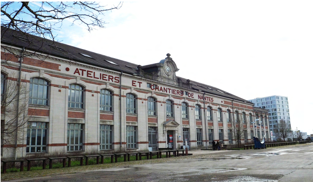
1. Ateliers et Chantiers de Nantes. El edificio, construido entre 1914 y 1917 siguiendo el diseño del arquitecto René-Charles Ménéard, acogía la dirección de las navieras. Tras su rehabilitación, en 1994, alberga la Maison des Hommes y Techniques. Fotografía: María Zapico López.
