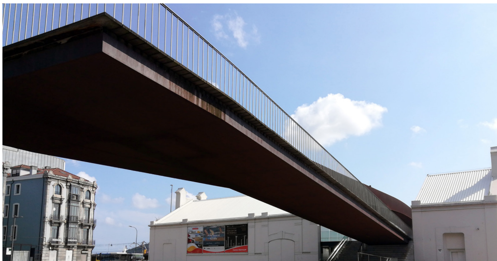
8. La pasarela peatonal o “grapa” sobre la ría de Avilés se ha servido del edificio de la Pescadería Municipal como simple estructura portante del nuevo elemento urbanístico, anulando su interés patrimonial. Fotografía de la autora.
