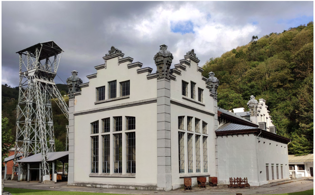
7. Pozo San Luis de Carbones de La Nueva en Langreo. La impecable rehabilitación de la casa de máquinas es responsabilidad del arquitecto Carlos Marqués. Fotografía: Faustino Suárez Antuña.
