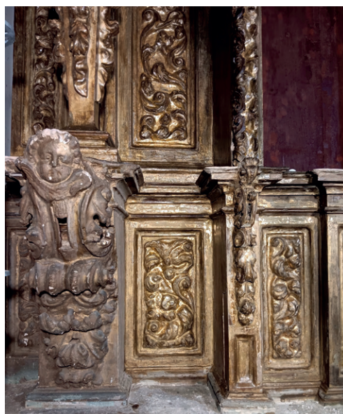
9. Estado de las obras durante la limpieza.
