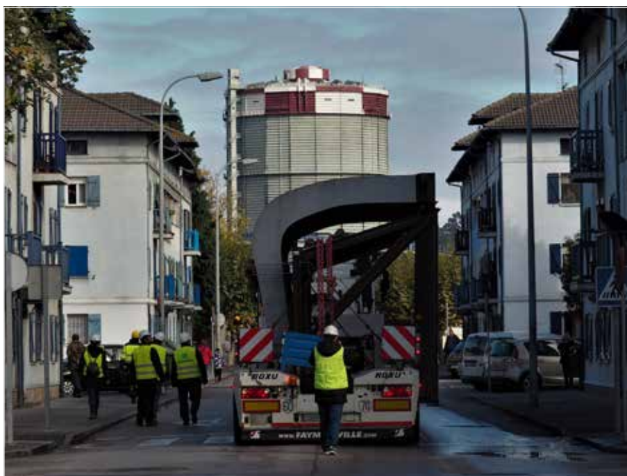
5. Traslado de la marquesina de La Rocica, tras la paralización de su demolición. Foto: Daniel Fernández García.
